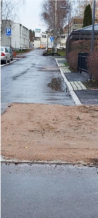
Kuva 10 Kisapolku 15.11.2022 katusaneerauksen jälkeen. Juholankadun jalkakäytävä avattu uudelleen, jäänyt asfaltoimatta.
